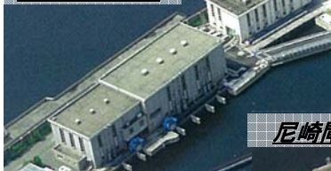
東浜排水機場
